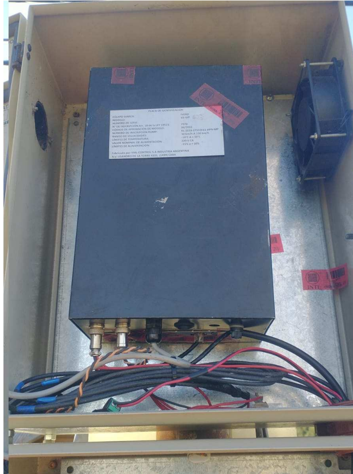
Vista interior del gabinete de alimentación 220 VCA
