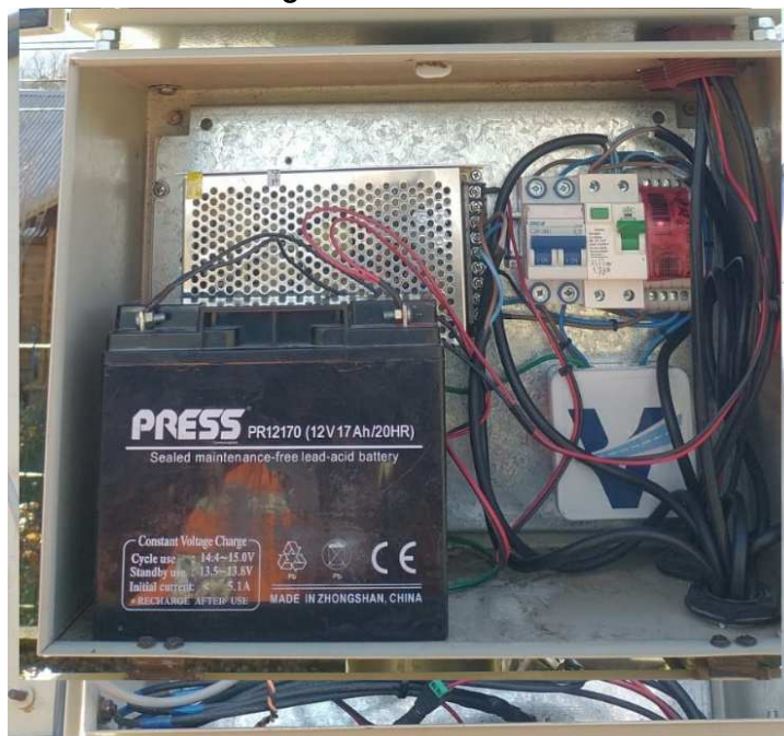
Vista interior del gabinete de alimentación 220 VCA
